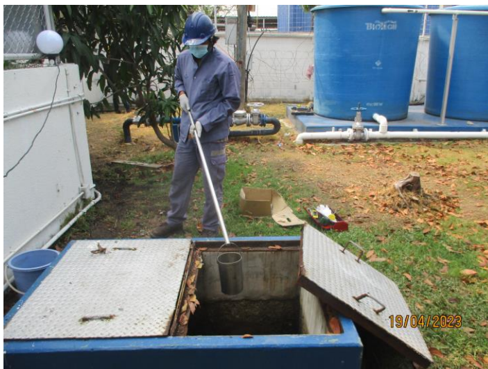
บ่อตรวจสอบคุณภาพน้ำทิ้ง (Inspection Pit)
